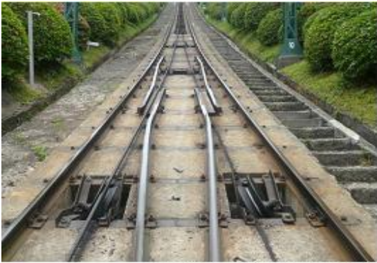
写真1 複線ポイント部分
